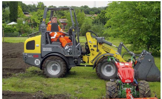
... und der Schaufellader wurde auch benötigt.
